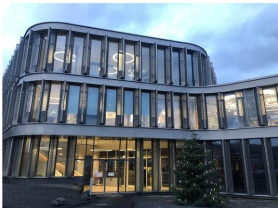
Figura 3: sostenibilidad también en la central corporativa WI.com: la fachada del edificio se adapta a las condiciones climáticas y sirve de aislamiento térmico. Copyright: WIKUS-Sägenfabrik
