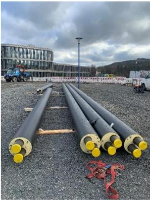
Abbildung 1: Die Rohrleitungen sind mit einer starken Dämmung ummantelt, um möglichst keine Energie nach außen abzugeben. Copyright: WIKUS-Sägenfabrik
