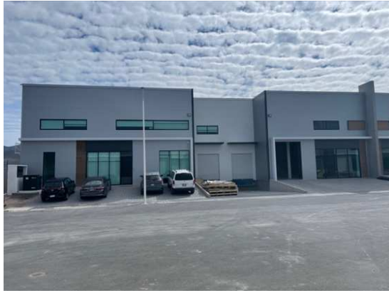
Fig. 4 : Vue de l'extérieur du nouveau bâtiment de WIKUS au Mexique. Source : WIKUS-Sägenfabrik
