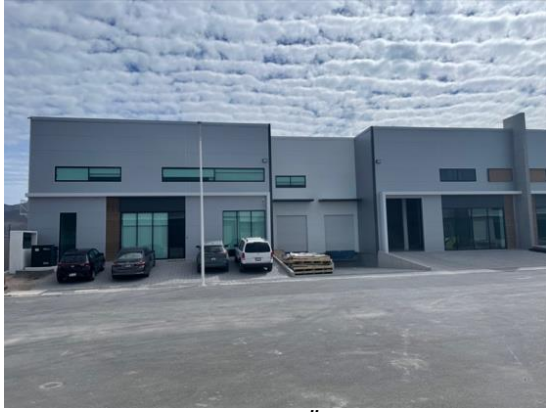
Abb. 4: Ein Blick auf das Äußere des neu errichteten Firmengebäudes von WIKUS in Mexico. Quelle: WIKUS-Sägenfabrik
